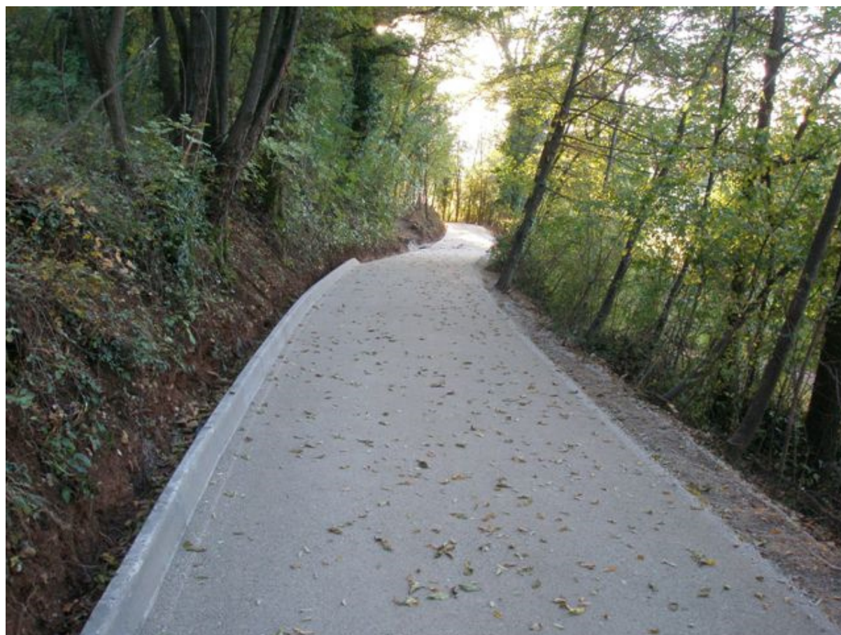
Figura 6.1: Strada in terra battuta, stabilizzata con la tecnologia eco-compatibile di sali inorganici (Moniga del Garda – Brescia).
